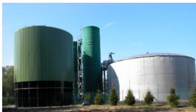
Station de traitement des eaux usées d'une entreprise agroalimentaire / Waste water treatment plant of a food-processing industry, FRANCE
