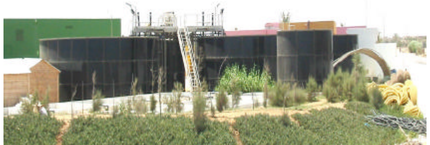
Station d'épuration des eaux d'un club de vacances / Waste water treatment plant for a holiday camp, TUNISIE
