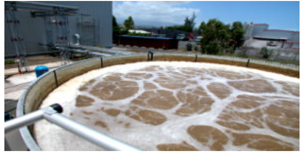
Bassin d'aération pour une entreprise d'équarrissage / Aeration tank for a quartering industry , LA REUNION
