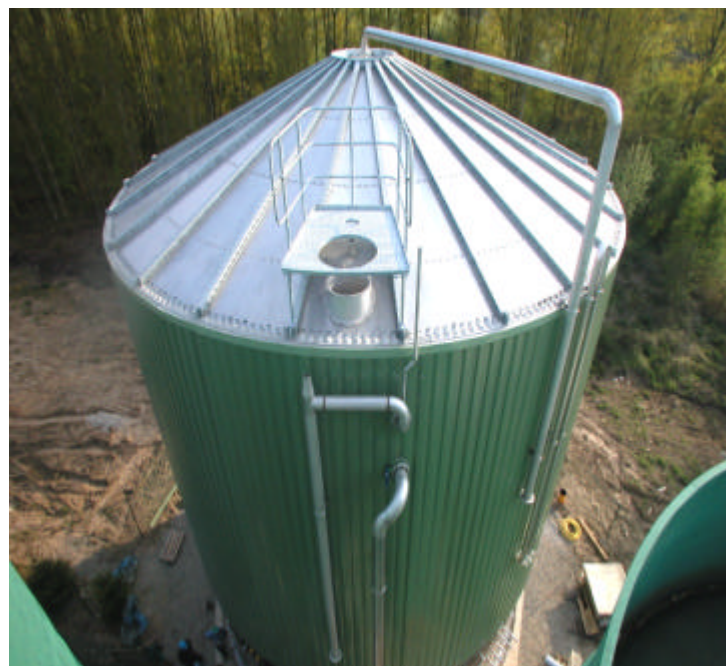
Silo à boues / Sludge silo
