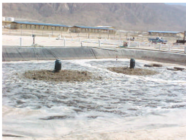
Lagune d'aération / Aeration pond
