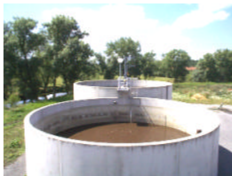
Bassin en béton / Concrete tank
