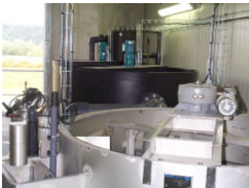
Traitement physico-chimique des effluents d'une usine de lavage / Physico-chemical treatment of effluents from a washing plant, FRANCE
